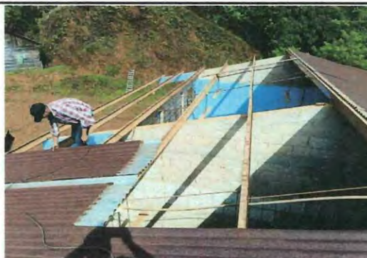
Foto: Instalación de Láminas Troqueladas de 3 Aulas, Dirección y Bodega.
