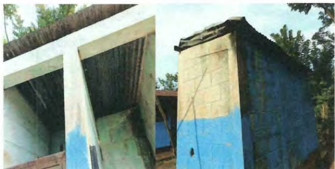
Foto 7: MODULO II: Mantenimiento de estructura de baño y Sustitucion de lámina acanalada a troquelada.
