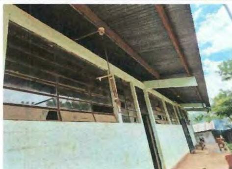
Foto: Mantenimiento de balcones.
