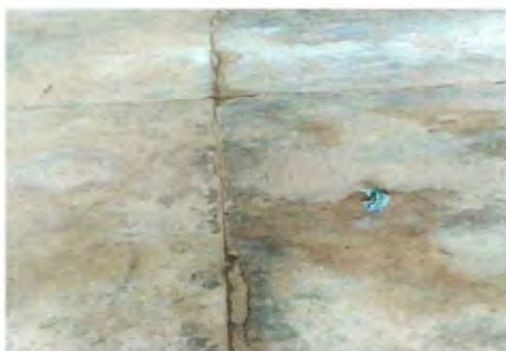
Foto 9: MODULO III: Reparación de piso.
