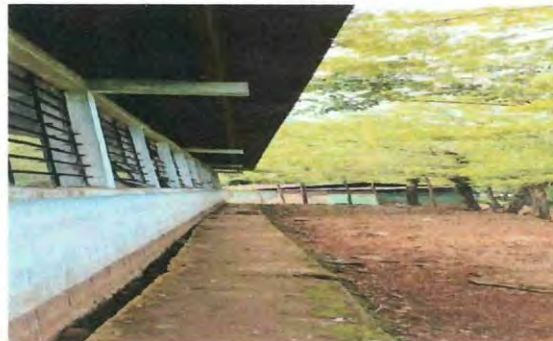
Foto 8: MODULO III: Cambio de entortado.
